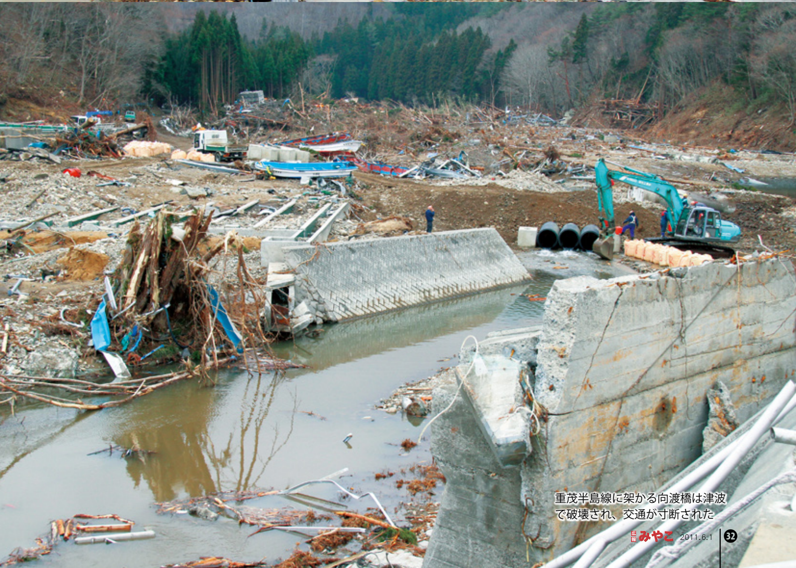
重茂漁港（里）。製氷冷蔵工場やアワビの種苗生産施設などが失われた
