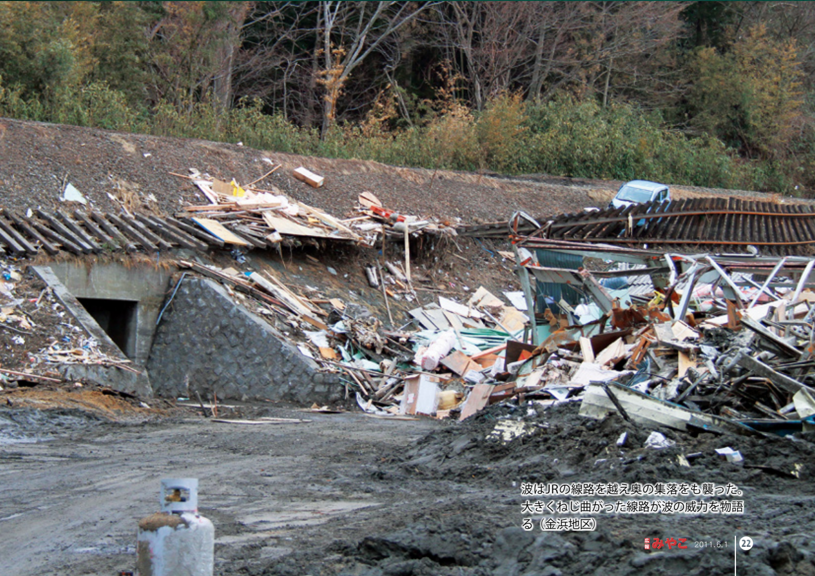
被災後の高浜地区。防波堤を乗り越えた波は 国道45号から一気に集落に流れ込んだ
