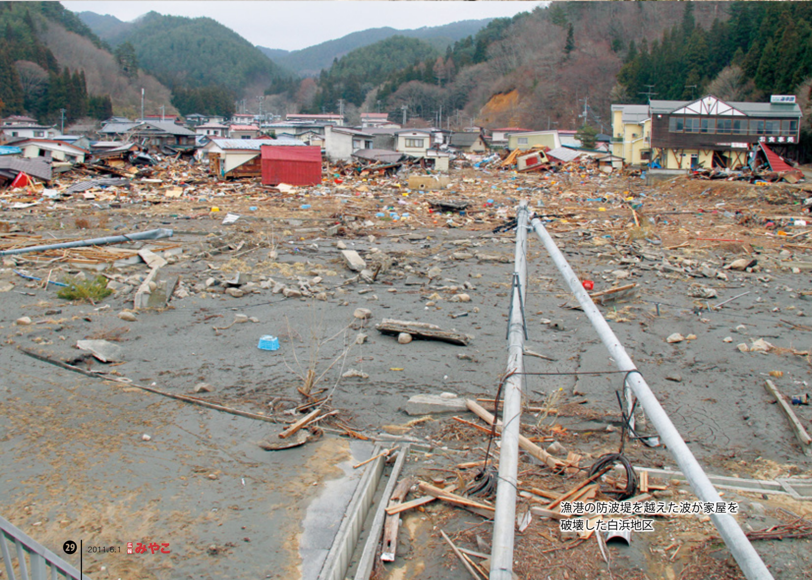
津波の威力により脱線したJR 山田線の車両（津軽石駅構内）
