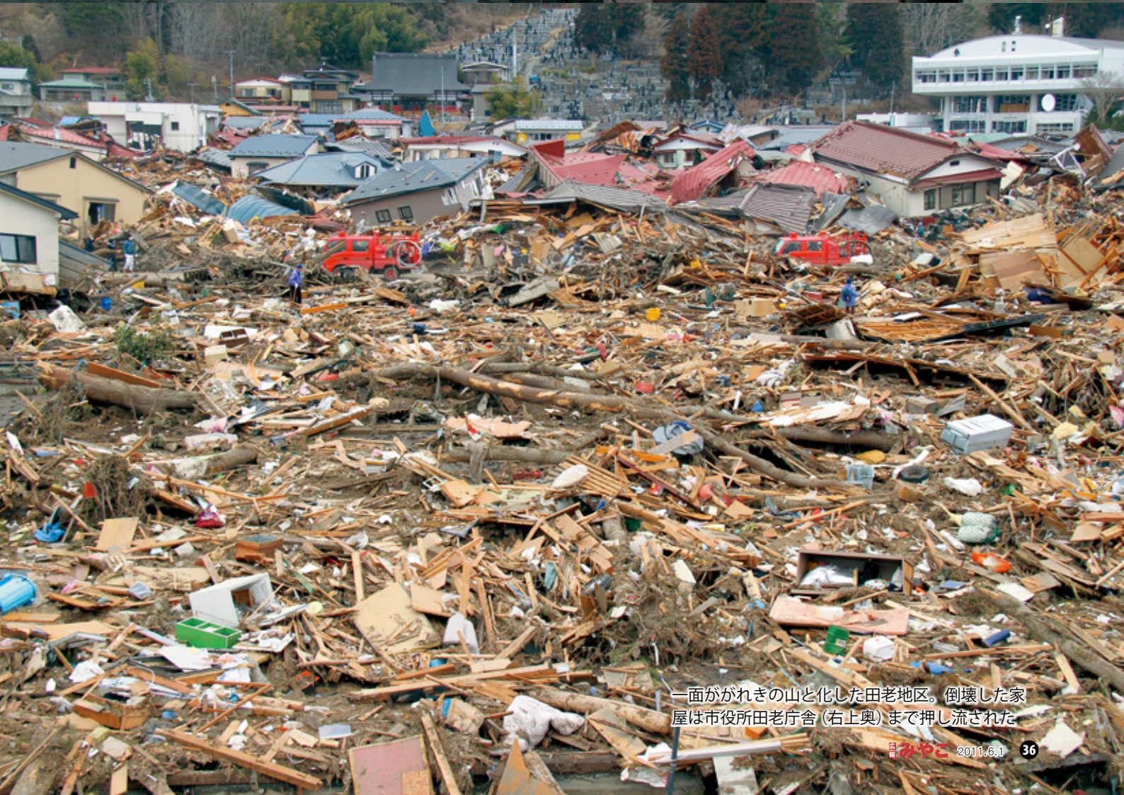
大防潮堤をいとも簡単に乗り越え、一気に流れ込む津波（提供：田老町漁業協同組合）
